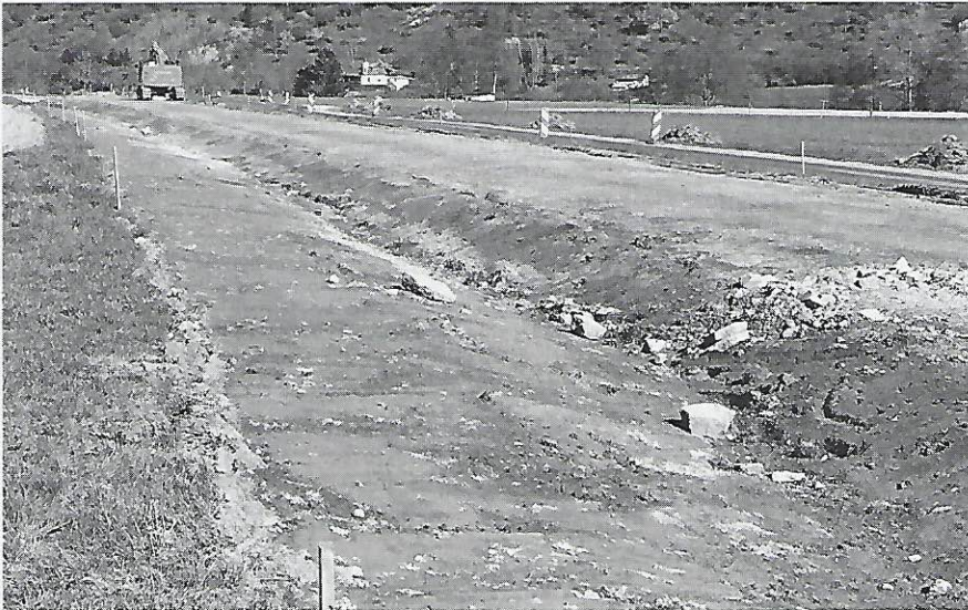
Der Aushub der Staatsstraße wird jetzt für einen „guten Zweck“ verwendet - dem Sportplatz.
