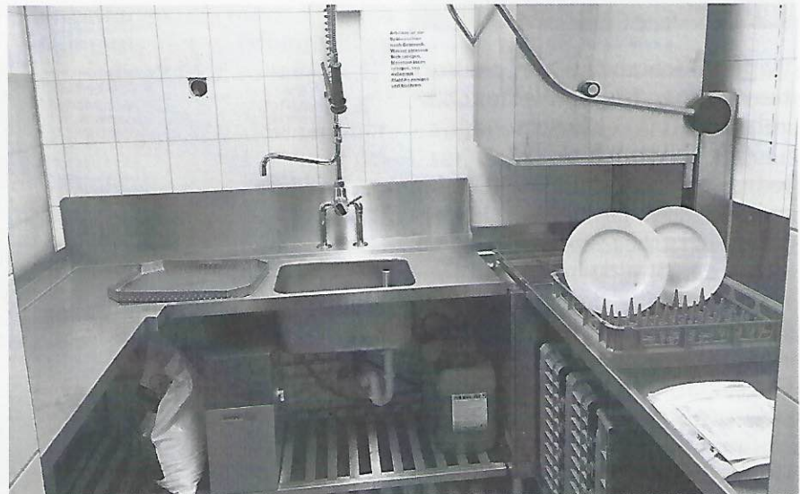
Die neue Spülküche erleichtert die Arbeit und optimiert den Ablauf während der Veranstaltung.
