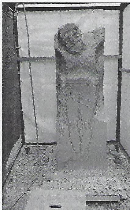
Der Korpus wurde in Handarbeit komplett neu aufgebaut - selbstverständlich originalgetreu.
