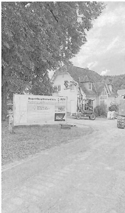
Das Zentrum von Aura ist nun Großbaustelle ...
