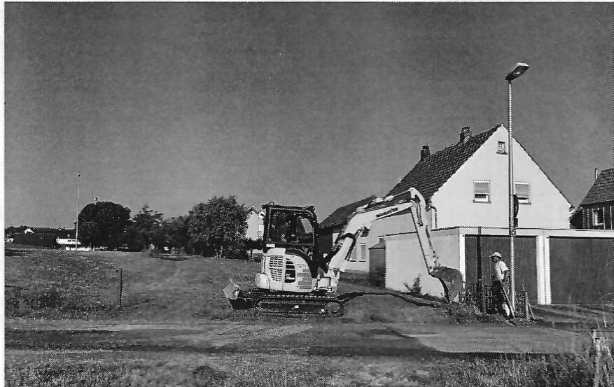
Mit entsprechendem Gerät wird die neue Zuleitung für die Sportplatz-Bewässerung angegangen.
