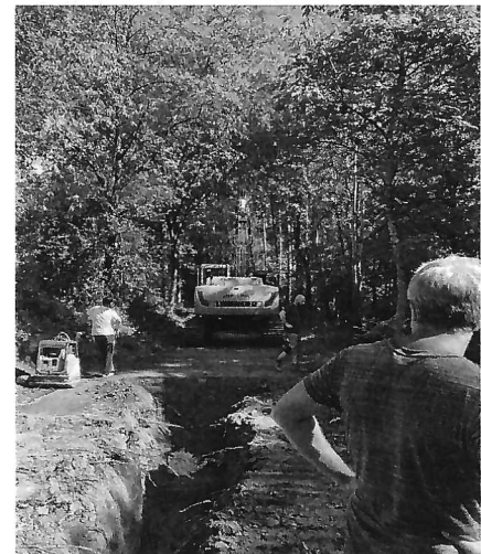
Radweg und Wasserleitung nach Wittershausen: eine Baustelle - reduzierte Kosten.
