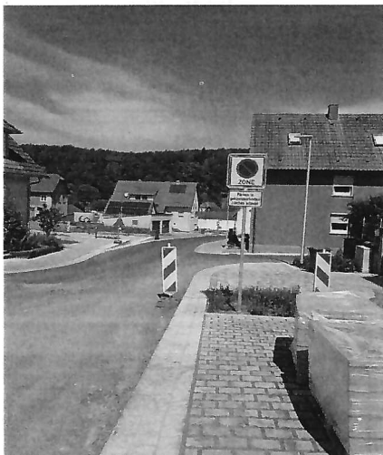
Neuer Ortskern: Die „Zehnt“, erhält nun noch den „Feinschliff“ ...
