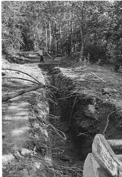
Der Leitungsbau nach Wittershausen ...
